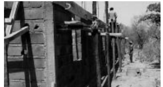
La nouvelle école en construction
